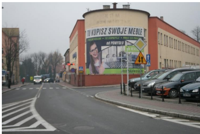
Rysunek 38. Budynek Domu Rzemiosła w Kalwarii Zebrzydowskiej
