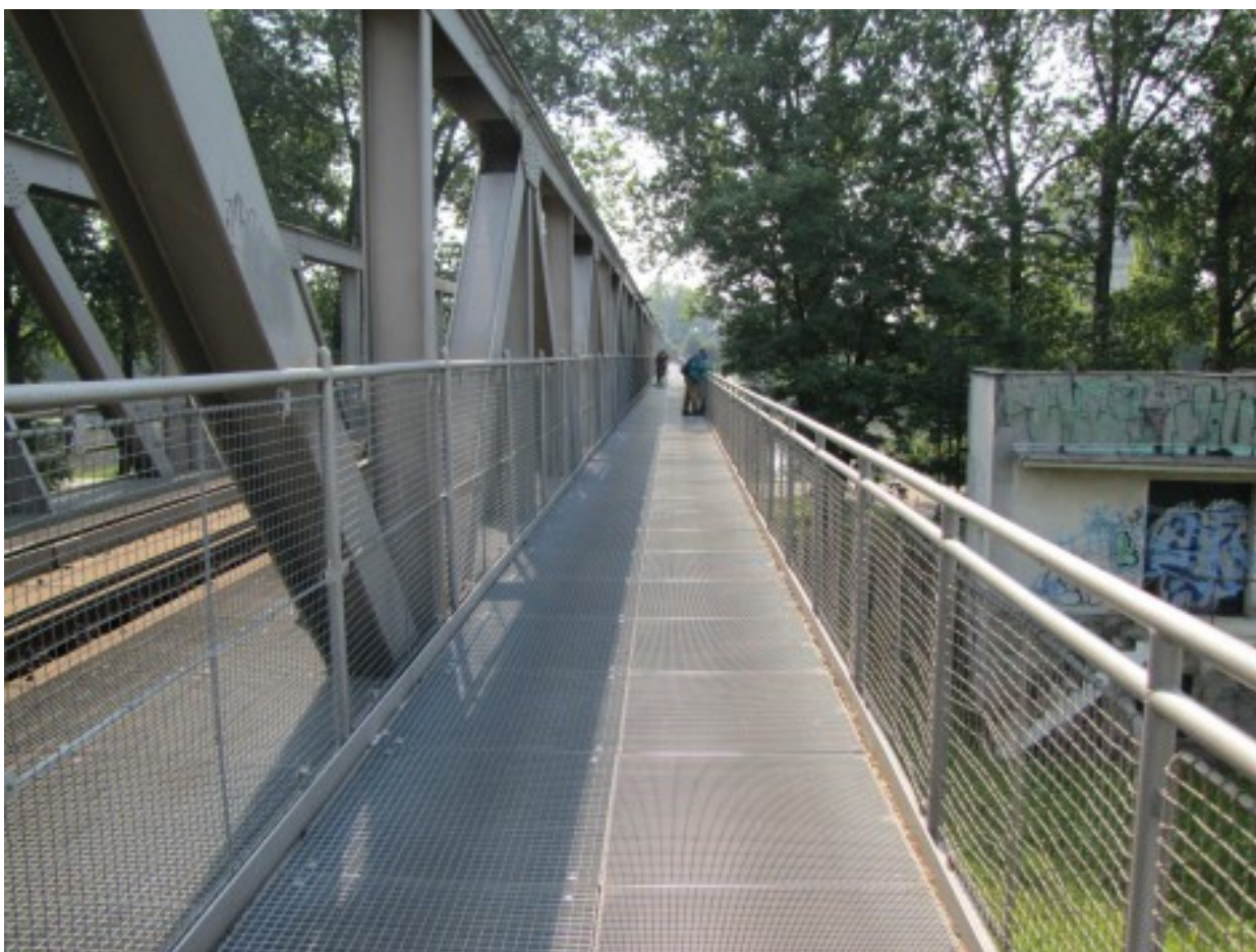
Ilustracja 8: Przykład podwieszenia kładki rowerowej do mostu kolejowego.
